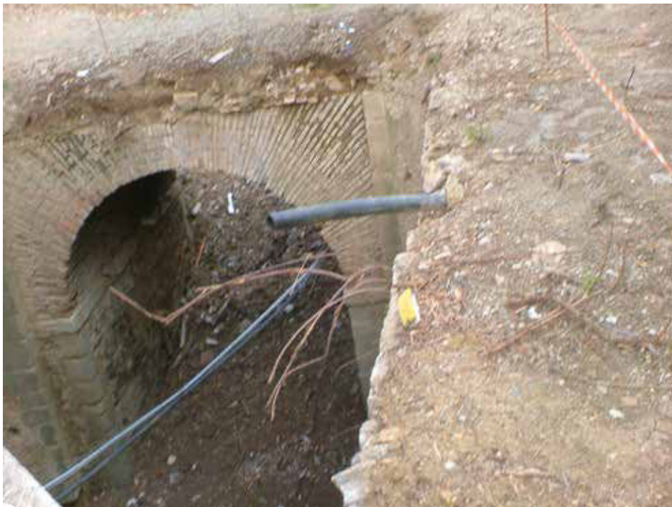
Fig. 4 - Il ponte presumibilmente romano. Ben visibile l'orditura dei mattoni
