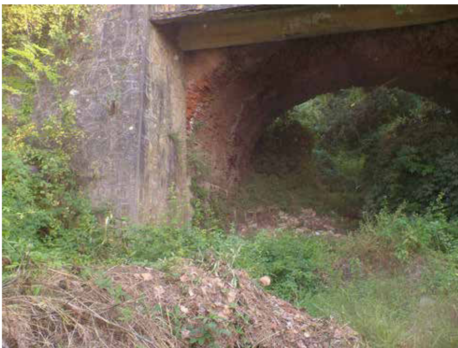
Fig. 5 - Un'altra vista del ponte a cui è accostato un manufatto recente in cemento armato
