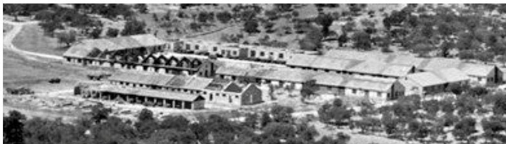
Figura 4. Particolare ingrandito dei capannoni militari di figura 4.
