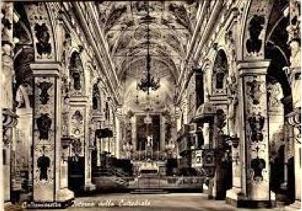
Figura 7. L'interno della Cattedrale di Santa Maria la Nova prima del bombardamento.
